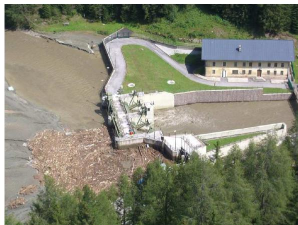
**Abbildungen 16/17.** Staudamm Pfitsch mit Holz- und Heuballenablagerung im Bereich der Schleusen (links) und Restwasserkanal direkt unterhalb der Pegelmessstelle Kodek 3365 (rechts).
