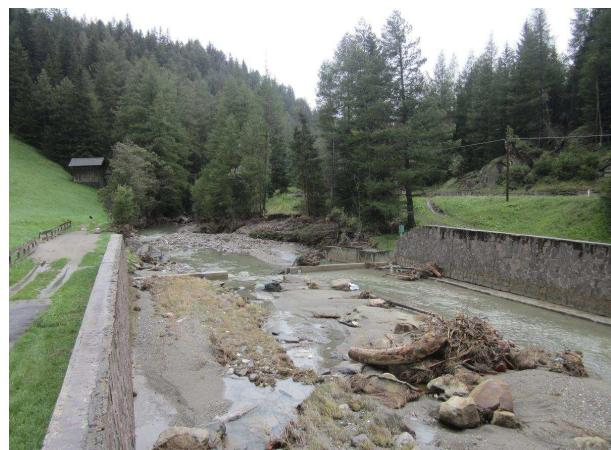
**Figure 16/17.** Diga di Vizze con accumulo di legname flottante e balle di fieno in prossimità delle paratoie (a sinistra) e stazione idrometrica codice 3365 subito a valle della stessa (a destra).
