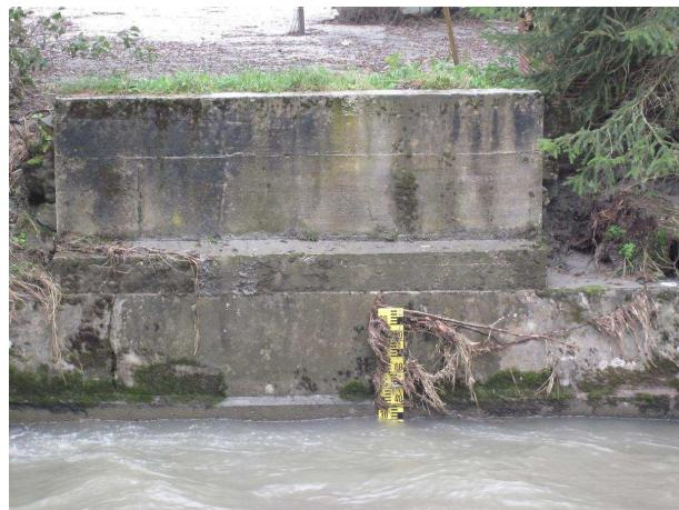
**Figure 14/15.** Esondazione del rio Vizze nella zona della stazione idrometrica di Novale (a sinistra) e dettaglio dell'asta idrometrica e dello scalzamento della passerella di misura (a destra).
