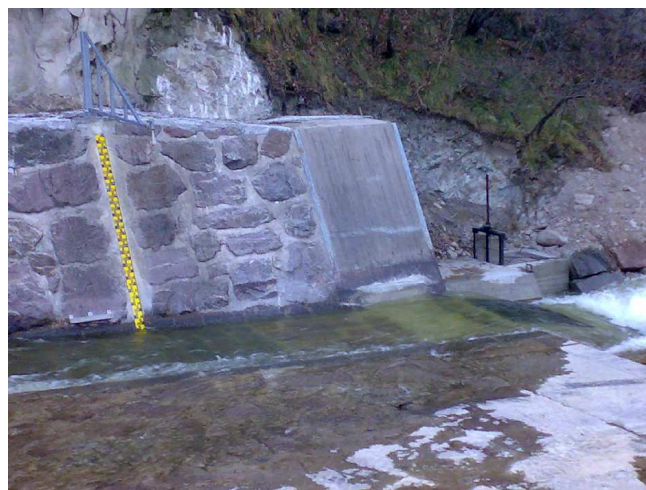
Abbildungen 1/2. Pegelstation am Eggentalerbach in Kardaun. Links vor und rechts nach den außerordentlichen Umbauarbeiten im Winter 2009.
