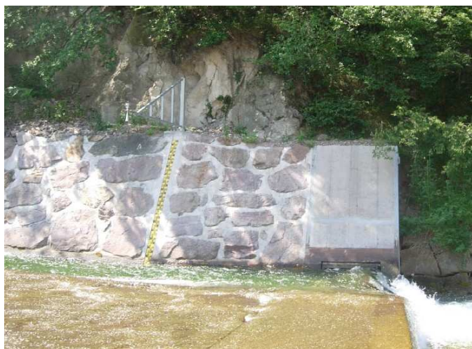
Figure 1/2. Stazione idrometrica rio Ega a Cardano prima (a sinistra) e dopo (a destra) l'intervento di manutenzione straordinaria realizzato nell'inverno 2009.
