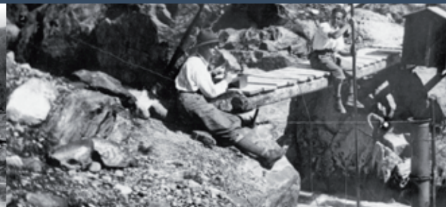
Pegelstation (1929) Stazione idrometrica (1929)
