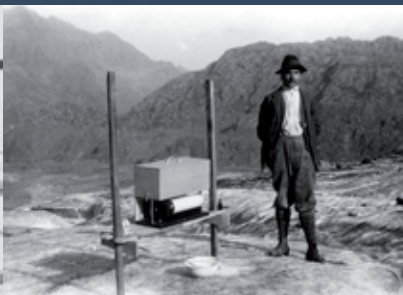
Installation eines Ablationsmessgeräts Installato l'ablatografo
