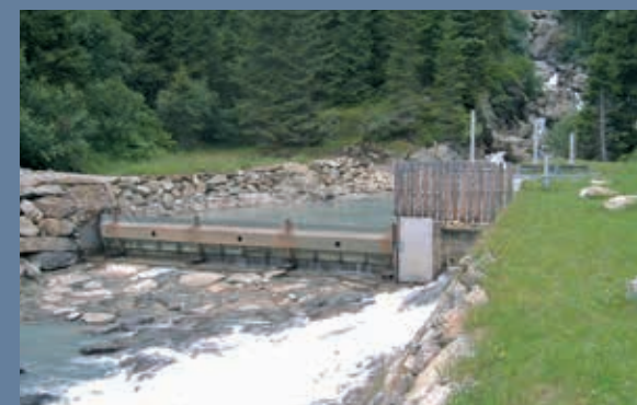
Wasserfassung des E-Werks am Fernerbach Opera di presa dell'impianto idroelettrico sul rio Ferner
