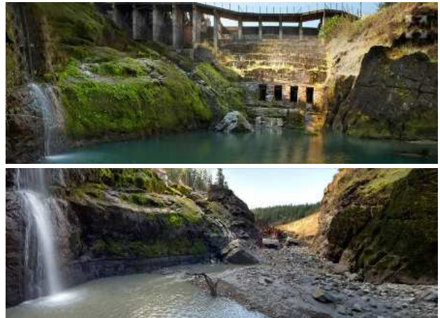
Figure 1. e 2. Corografia con ubicazione ell'Elwha River sulla costa pacifica degli Stati Uniti e diga omonima prima e dopo la demolizione.
