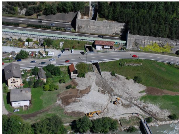
**Abbildung 2/3.** Aufräumarbeiten in Franzensfeste nach den Murenabgängen auf die Staatsstraße (links) und nahe der Brennerautobahn (rechts).
