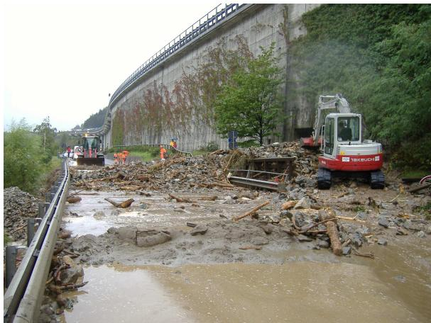
**Figure 2/3.** Lavori di sgombero del materiale depositatosi sulla strada statale (a sinistra) e nelle vicinanze della A22 (a destra) presso Fortezza a seguito di due distinte colate detritiche.
